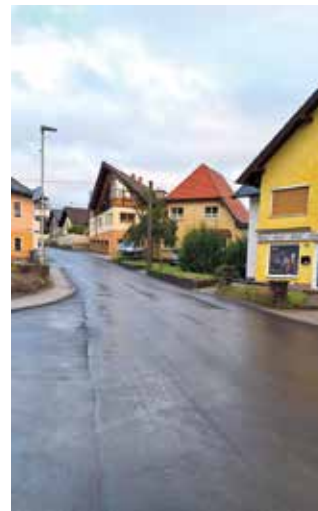
Die Vöcklabrucker Straße wurde zwischen GH Reiter und Raika einer Belagssanierung unterzogen.
