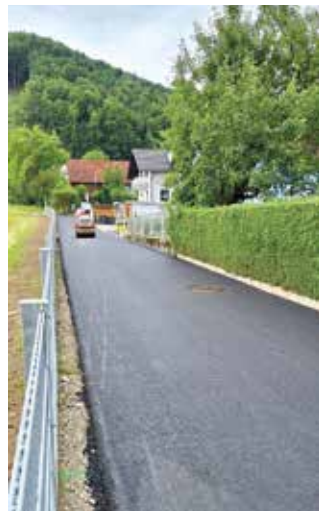
Der 1. Teil des Bergweges wurde ver- breitert und neu asphaltiert.
