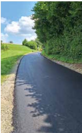
Komplettsanierung der Kufhausstraße.
